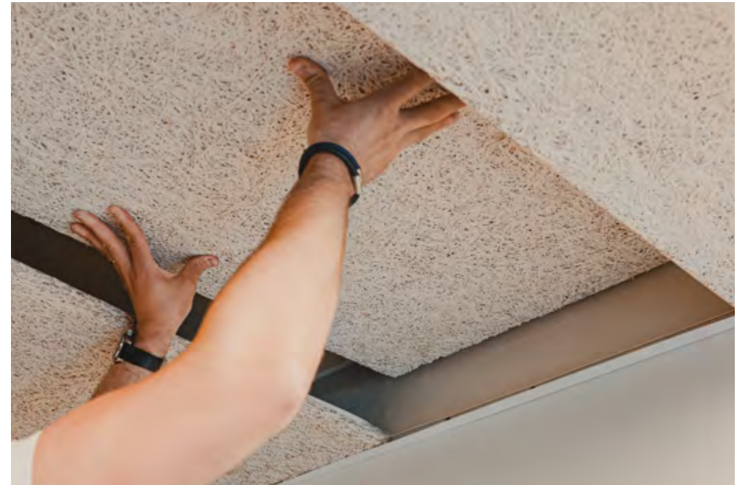
Korridorpanelen kräver endast vägglist för en bärande konstruktion men kan vid bredare utrymmen också placeras på T-profil. Den verktygsfria monteringen ger en effektiv och tidsbesparande installation och möjliggör för enkel demontering och återbruk.
